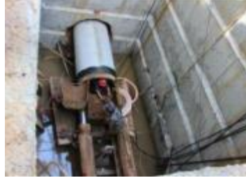
(e) 深基坑和地下管沟
