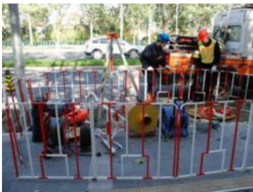
图 4-2 作业现场围挡
