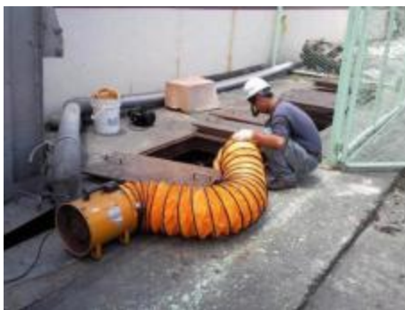
图 4-6 风机、风管的设置
